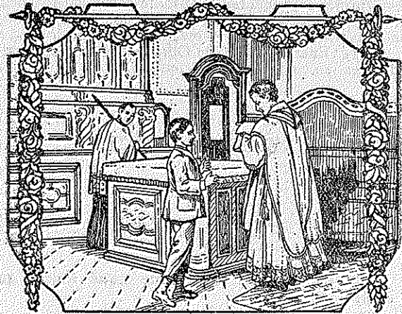
El comienzo de la gran obra...
